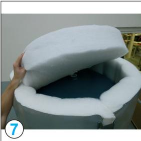
Deckelisolierung einlegen (Position der beiden Stützen beachten)
