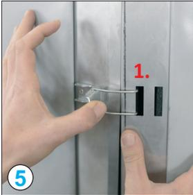
**Vorspannung:** Alle Verschlussbügel in den linken Schlitz (1.) einhaken und verschließen
