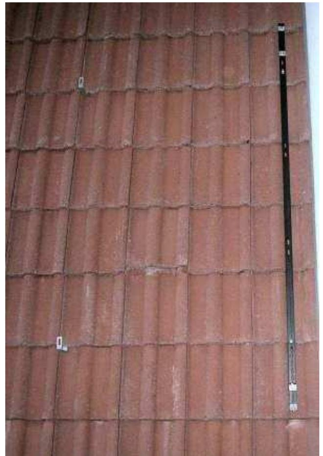
Bei dieser Befestigungsweise müssen die Dachhaken entsprechend den Kollektorrahmen und den Dachsparren montiert werden.
